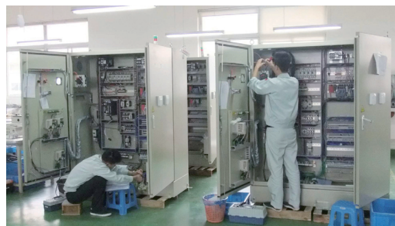
北越電研(上海)制御盤製造風景
