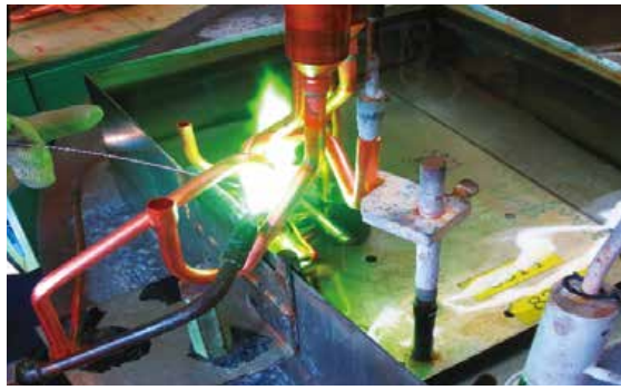
銅管の水溶接
