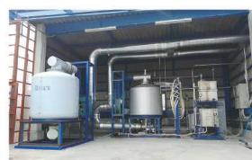
トリクロロエチレンの排出抑制施設。徹底した対策で、環境、そして従業員への安心・安全を確保している。
