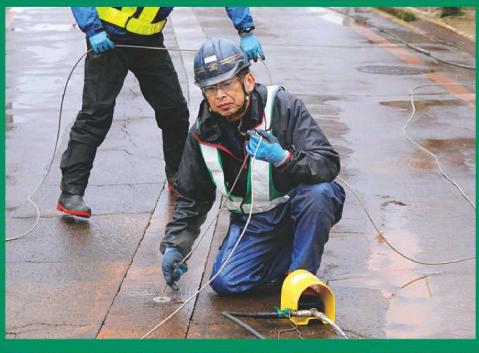
リバーサルクリーニングの作業風景。ノズルで洗浄すると、管の中にたまっていた砂泥や水垢、赤サビなどが一気に噴出してくれる。
