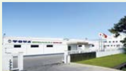
第3工場は水害から設備を守る防水工事を施しているのが特徴。ISOを取得し日本同様の生産管理と品質保証教育を行っている。また、ベトナム工場は全て3交代24時間体制が可能。現在、約750名の従業員が働いている。
